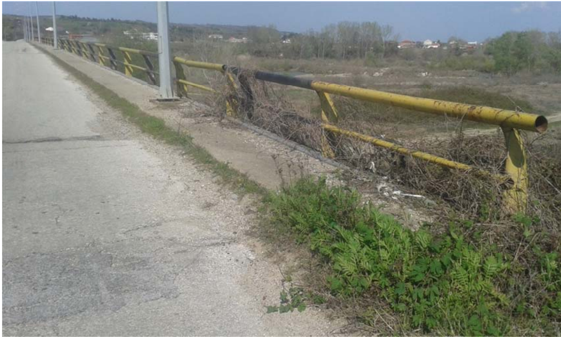
Διαδρομή διέλευσης στη γέφυρα ΚΥΠΡΙΝΟΥ-ΚΟΜΑΡΩΝ
