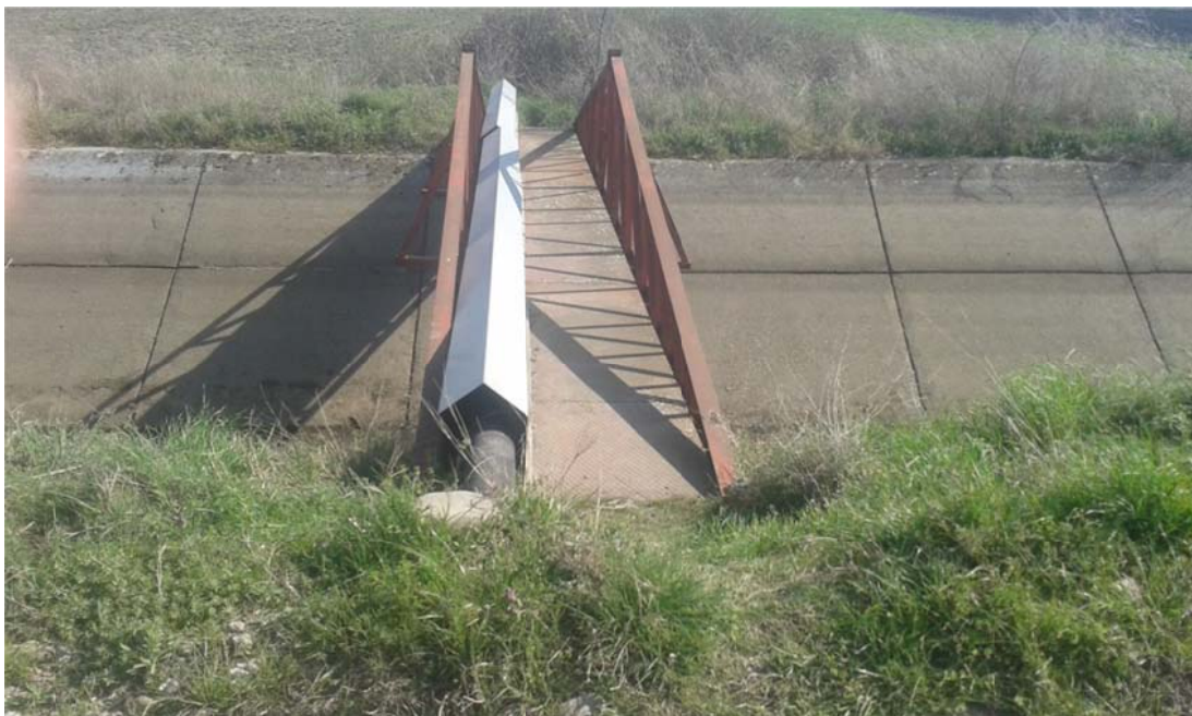
Τέλος διαδρομής στη διώρυγα ΚΟΜΑΡΩΝ και διασύνδεση με τον υφιστάμενο αγωγό
